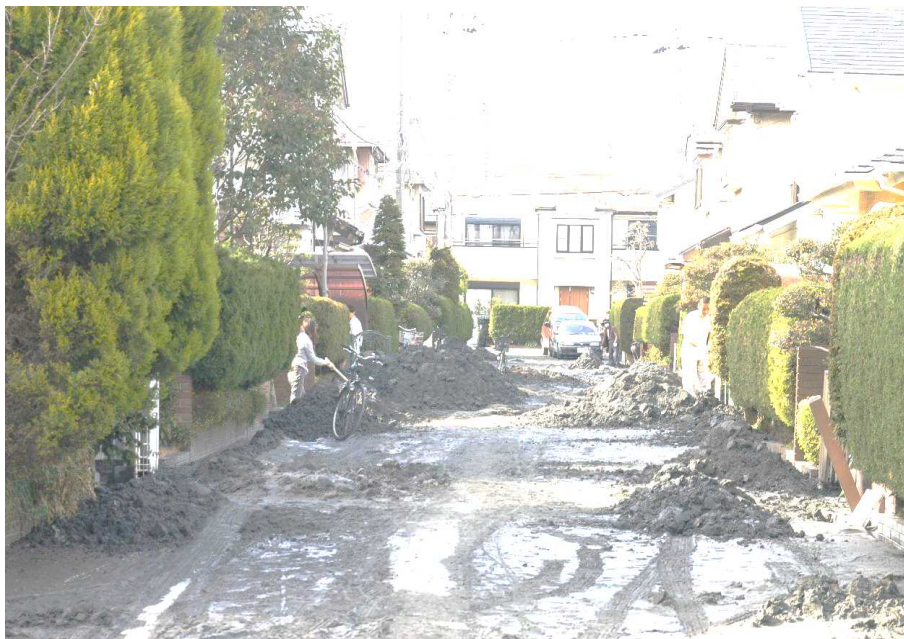
宅地内からの土砂搬出
