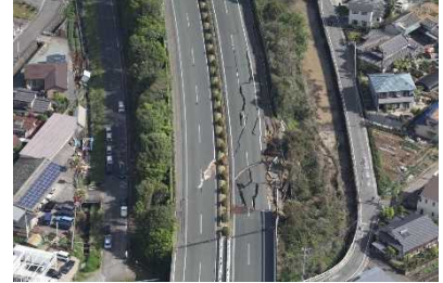
盛土法面の崩落(崩落延長約30~40m)
