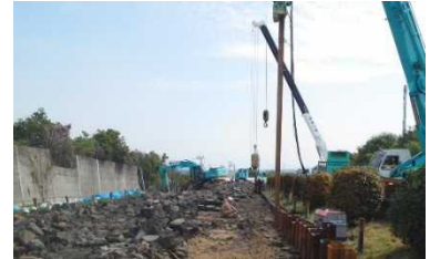
盛土の復旧工事实施中
