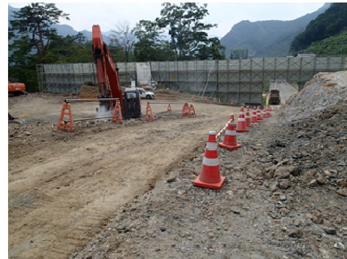
防じん壁の設置
