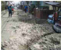
地表に噴き出した噴砂／千葉県千葉市
