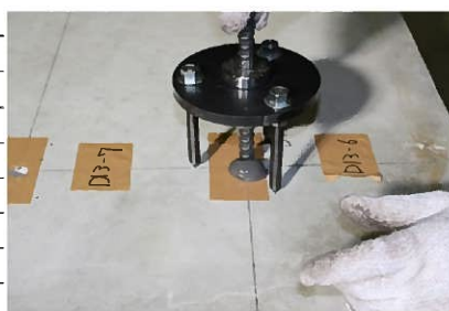
アンカー筋の固着状況写真
