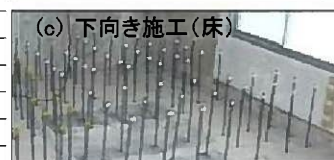
施工状況写真
