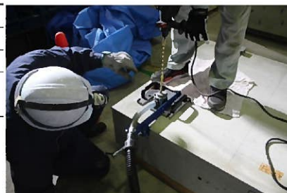
穿孔状況写真
