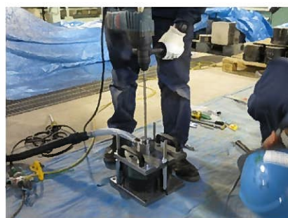
穿孔状況写真
