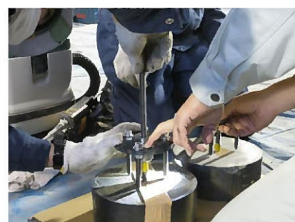
アンカー筋の固着状況写真
