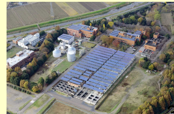
太陽光発電設備(巴波川浄化センター)
