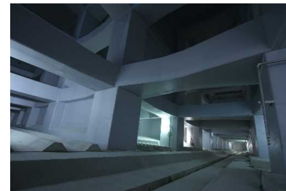
図4 雨天時貯留池
