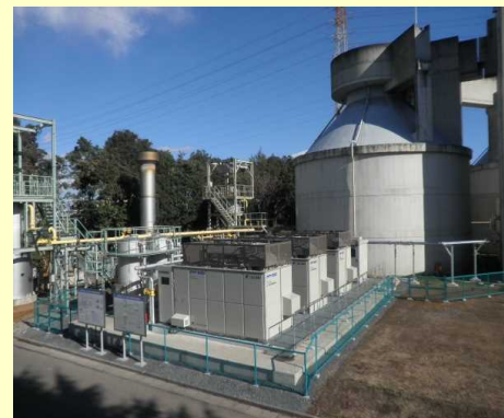
消化ガス発電設備(県央浄化センター)
