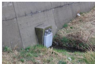
防潮堤内の排水用管渠 (フラップ式ゲート)
