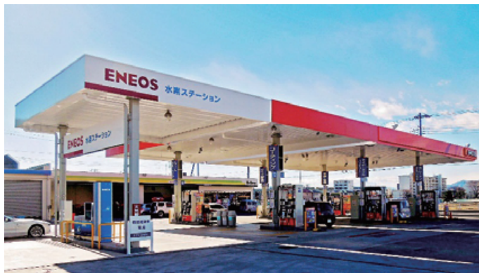
図表 1-4-5 SS併設型水素ステーション
