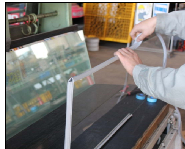
ガラスビニールの施工
