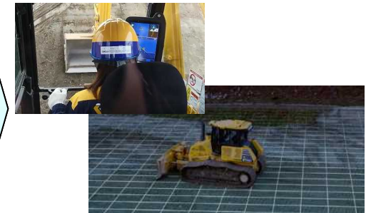
ICT建機による施工
