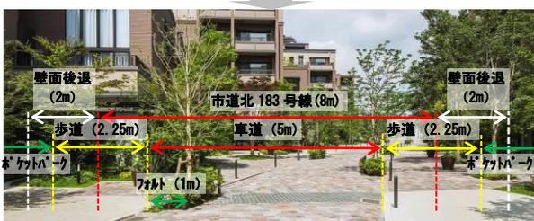
敷地北側にあった市道を中央へ付け替えコミュニティ街路とした。道路線形を緩やかに曲げ、車の速度の抑制と景観の変化を意図している。イメージハンブや植栽帯(フォルト)も配置。
