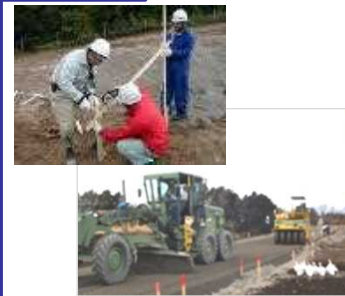
従来施工(丁張りによる施工)
