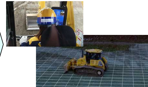
ICT建機による施工
