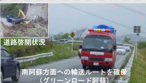
■ 道路啓開による輸送の確保
