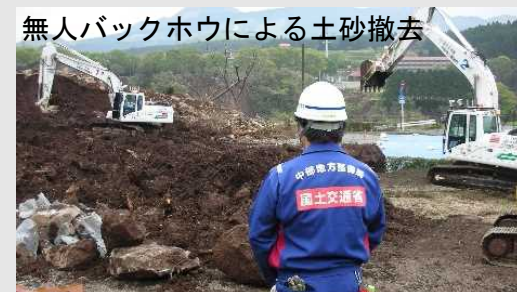
無人バックホウによる土砂撤去 ■ 先端的な災害対策用機械の活用
