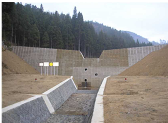
最上川水系 （山形県最上郡金山町） 『砂防堰堤（残存型柵）』
