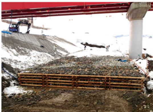
信濃川水系魚野川（新潟県魚沼市） 『木工沈床』
