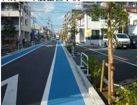
樹木の支柱 特別区道準幹線第30号 (東京都品川区)
