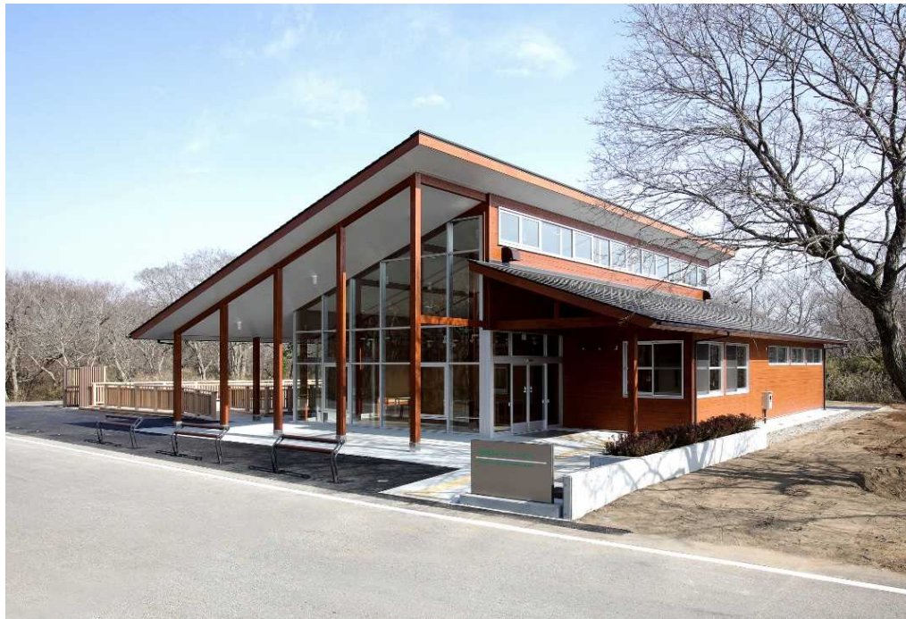
国営常陸海浜公園（茨城県ひたちなか市）：自然観察施設棟
