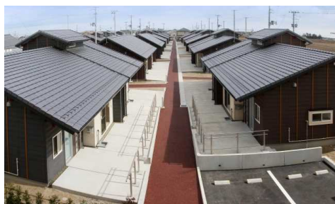
宮城県岩沼市 玉浦西地区災害公営住宅 外観
