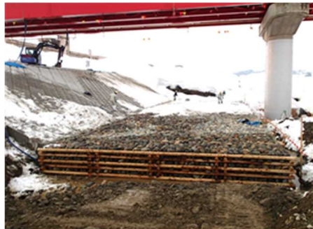
(河川) 信濃川水系魚野川 (新潟県魚沼市) : 木工沈床
