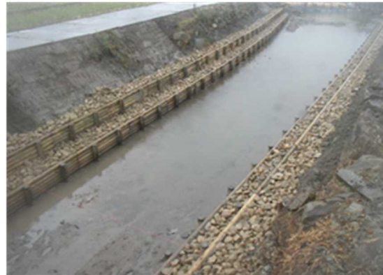
淀川水系安土川 （滋賀県近江八幡市安土町） 『杭柵工』
