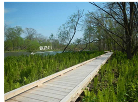
釧路川水系釧路川 （北海道上川郡標茶町） 『管理用通路工』
