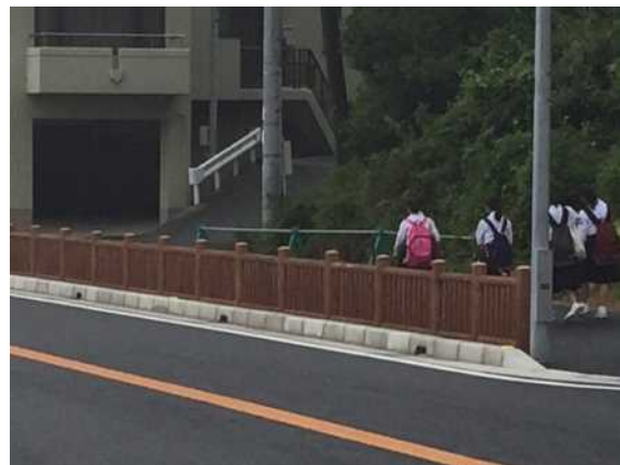
木製の歩行者自転車用柵 国道28号 (兵庫県淡路市)
