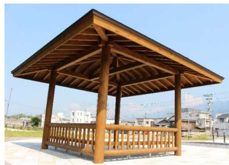
(港湾) 三島川之江港 (愛媛県四国中央市) : 休憩所
