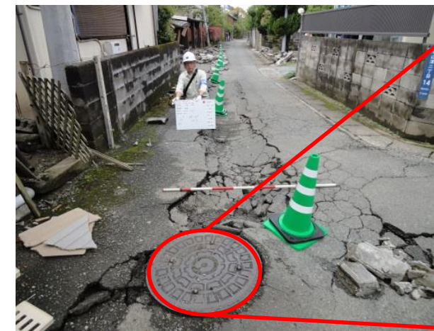
下水管の概略点検実施状況(写真②) (マンホールを開放して目視調査) ※マンホール内にズレは生じているが流下機能は確保
