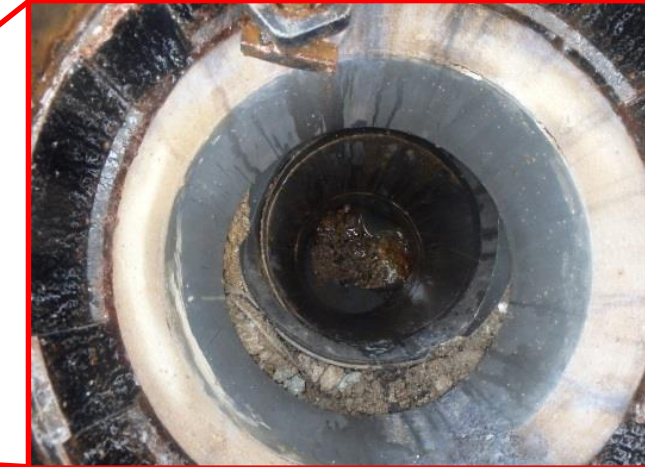
下水管の概略点検実施状況(写真②) (マンホールを開放して目視調査) ※マンホール内にズレは生じているが流下機能は確保
