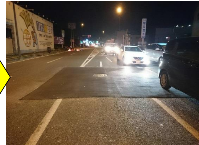
不具合箇所の応急対応(写真①) (下水管周辺の道路陥没舗装を仮復旧)
