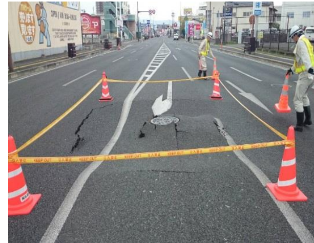
不具合箇所の応急対応(写真①) (下水管周辺の道路陥没舗装を仮復旧)
