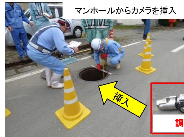
下水管の詳細点検実施状況 (テレビカメラによる下水管内部の調査)
