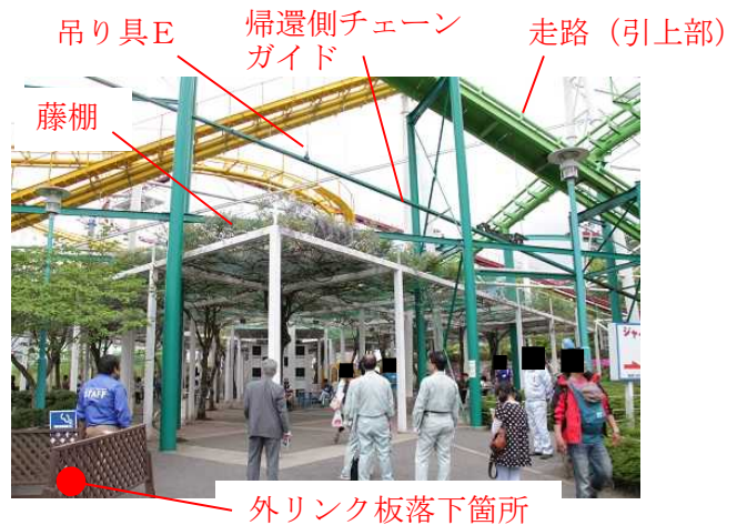
写真4 落下箇所付近
