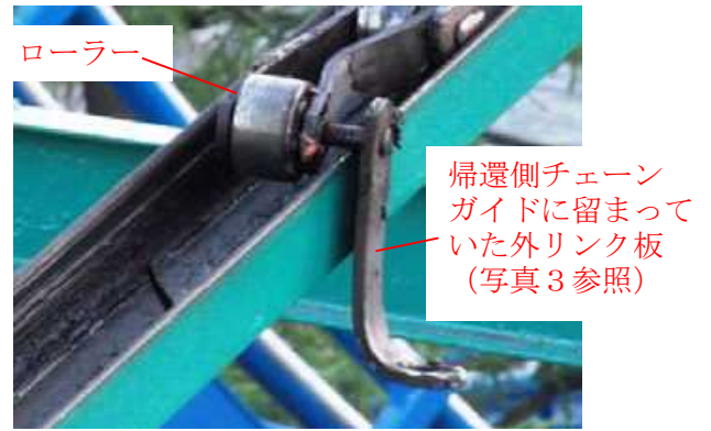
写真10 破断箇所(上側)
