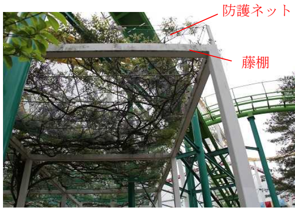
写真5 藤棚に設置されている防護ネット
