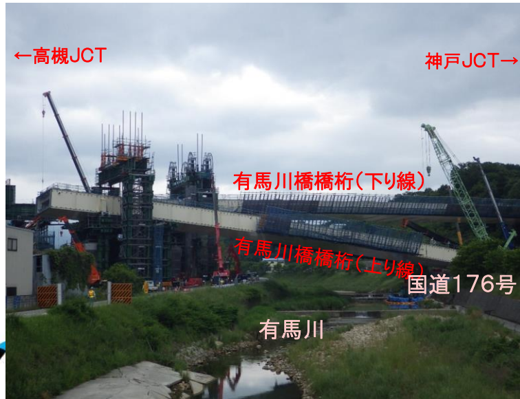
《有馬川橋橋桁落下事故の状況写真》
