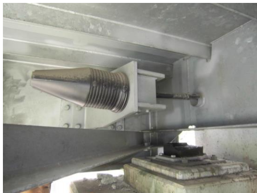
写真-3 落橋防止構造が効果を発揮した状況
