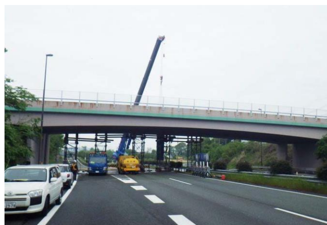
写真-1 橋梁概観
