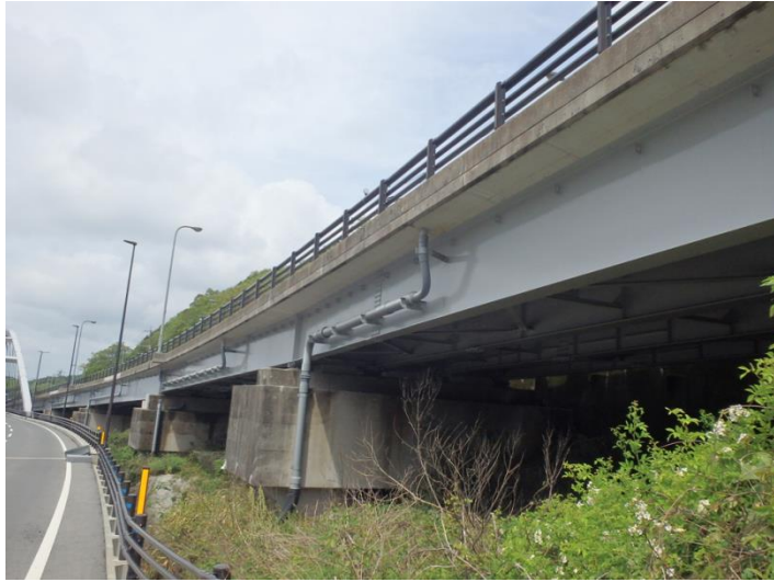
写真-1 橋梁概観
