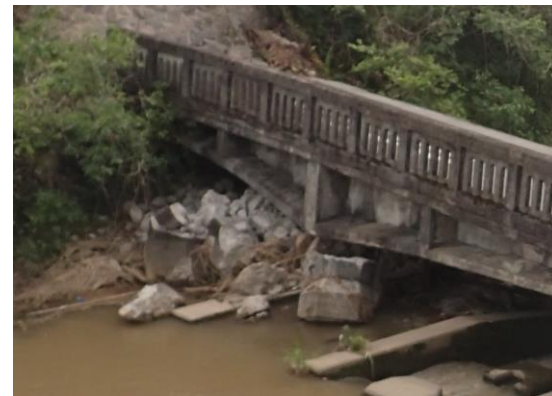
写真-4 左岸側橋脚
