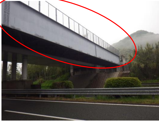
写真-1 橋梁概観
