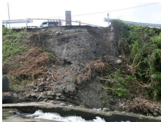
写真-3 左岸側橋台
