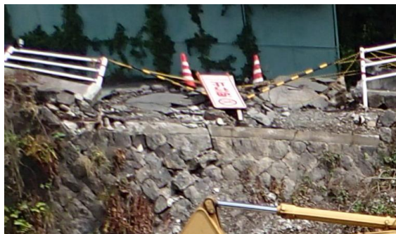
写真-2 右岸側橋台上部
