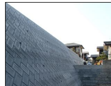
東日本大震災における災害関連地域防災がけ崩れ対策事業(特例) 実施事例
