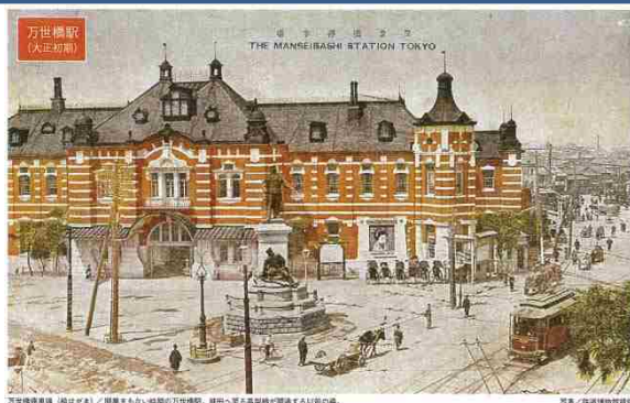
万世橋駅（大正初期） 万世橋駅（大正初期）／現存しない時期の万世橋駅。神田へ至る高架橋が架かる以前の姿。写真：交通博物館提供
