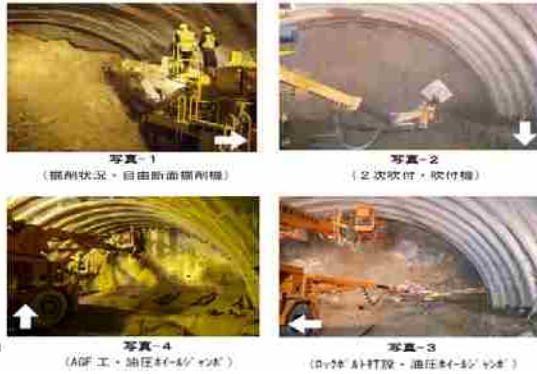
ロックボルト・先受け工 (AGF工) イメージ図
