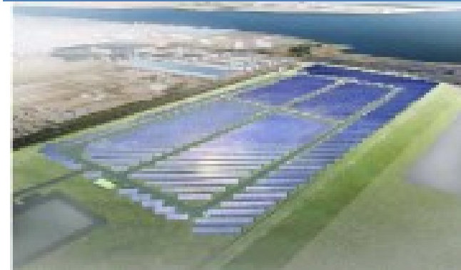
川崎港 浮島太陽光発電所
