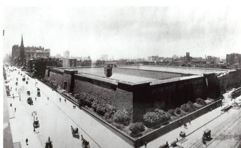
クロトン配水池
