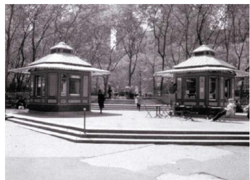
改修前の出入口
