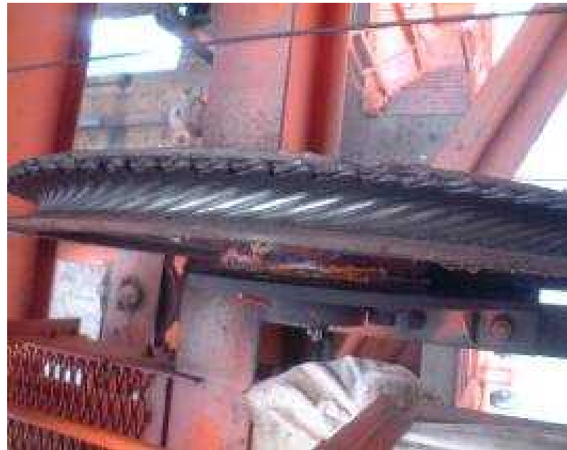
劣化度【a】主巻きシーブの条痕
