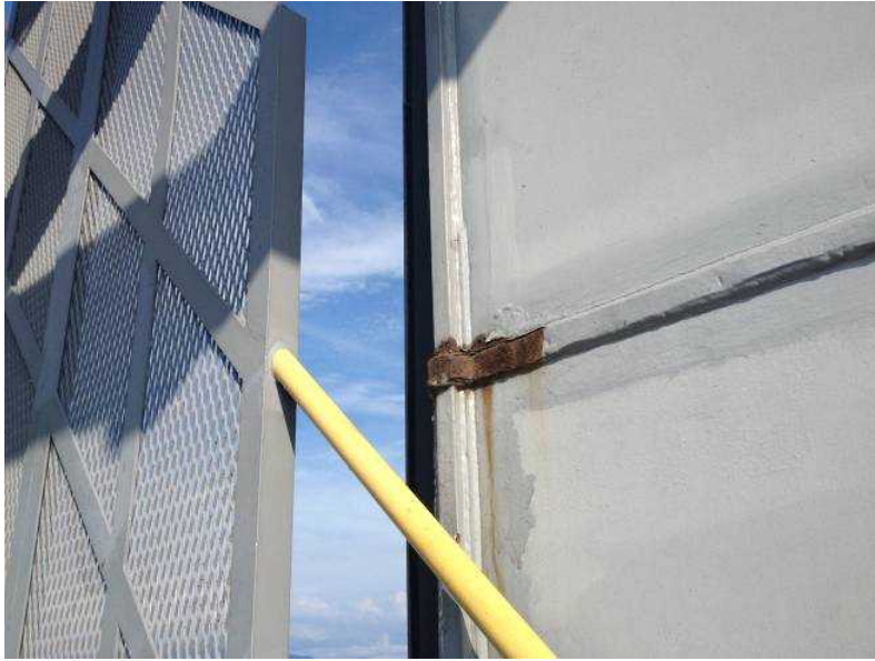
劣化度【b】脚部の塗装状況
