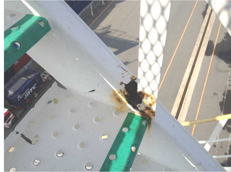
劣化度【b】階段手すり基部の腐食
