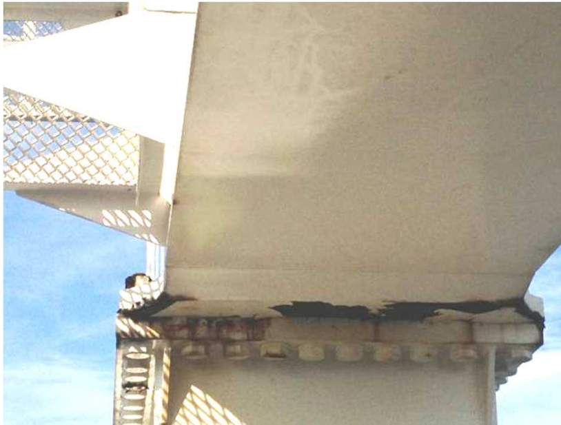
劣化度【a】タビーム下部の塗装状況
