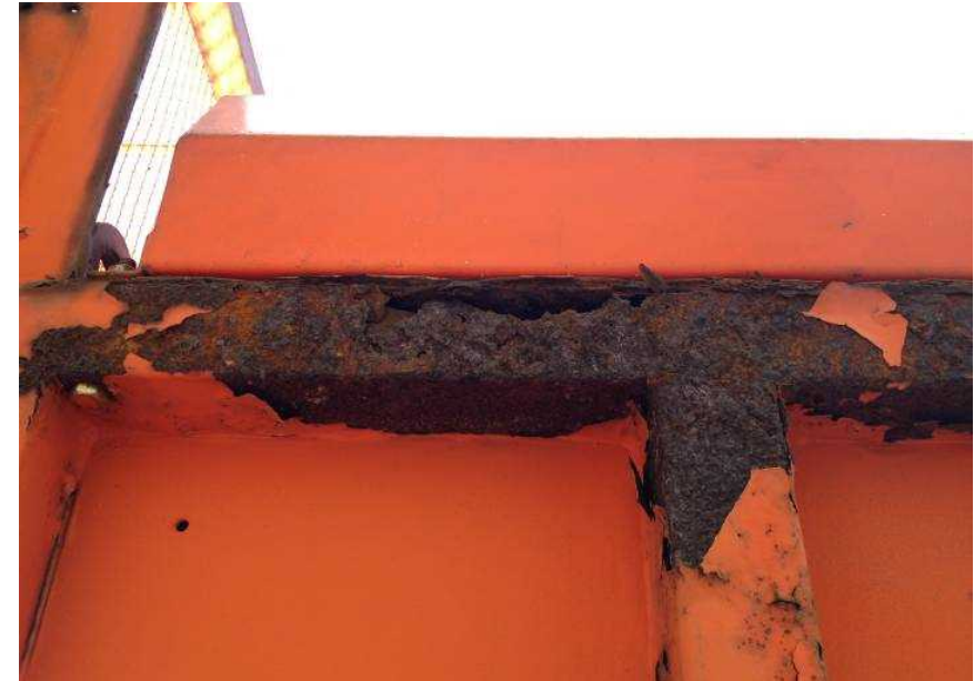
劣化度【a】鋼構造部の塗装状況
