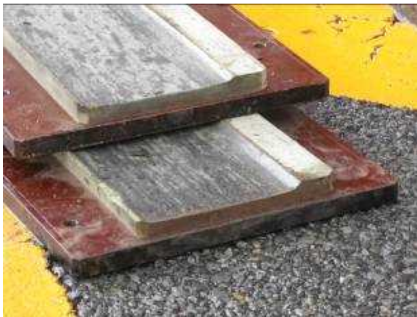
劣化度【a】レールブレーキ・パッドの状況
