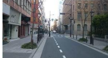
図 道路の美装化や 無電柱化の整備例 (大阪市)
