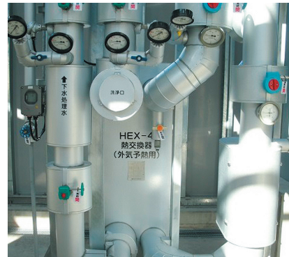
給湯・空調の熱交換機
