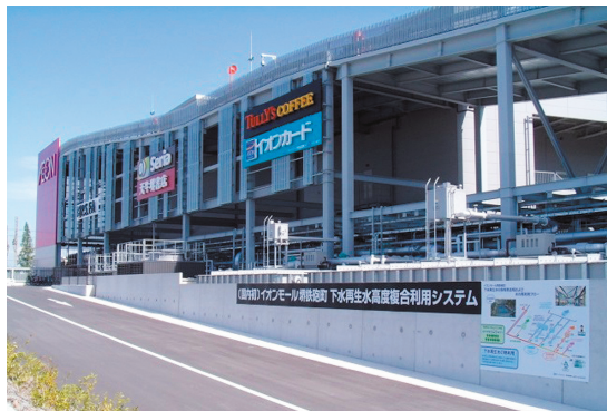
熱源利用システムを導入した 大型商業施設
