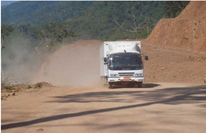
-ミャンマー国境ゲートより先はミタジャンクションまで全区間が未舗装道路である。
