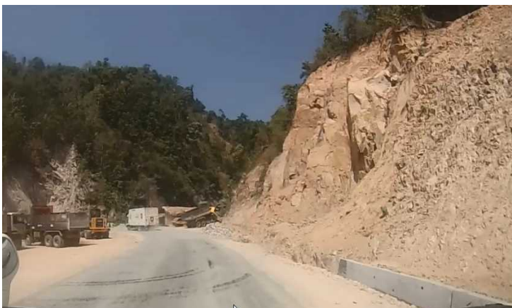
-TANINTHARYI REGION境界線以降の山岳部は一部、掘削跡のかけ崩れが懸念される。
