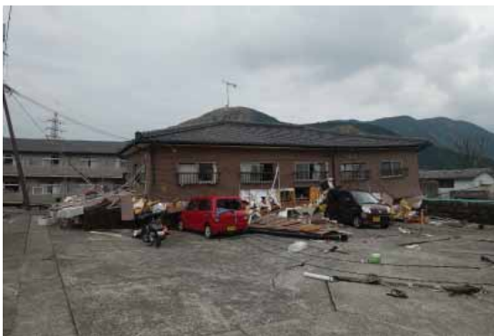
写真 3.3-14 倒壊した木造アパート
