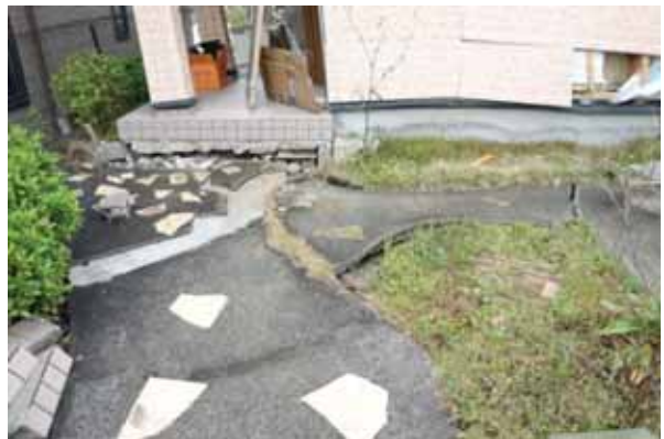
写真 3.6-5 地盤変状が認められるが、基礎の損傷が軽微・無損傷の事例
