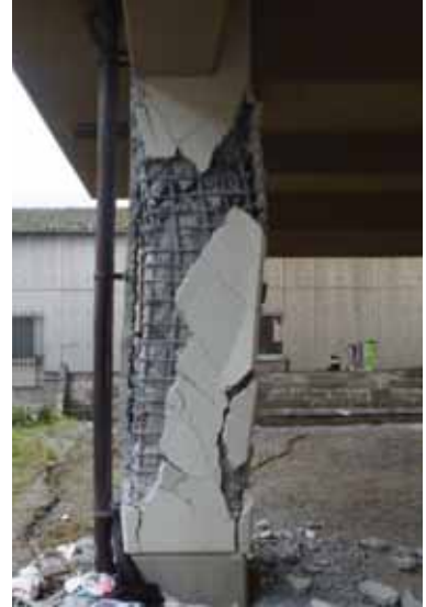
写真 3.5-3 付着割裂破壊した柱
