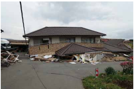
写真 3.3-16 倒壊した木造住宅
