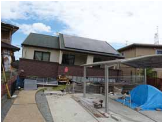
写真 3.3-4 倒壊した木造住宅
