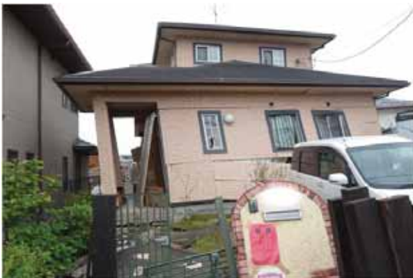
写真 3.6-5 地盤変状が認められるが、基礎の損傷が軽微・無損傷の事例
