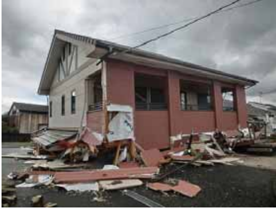
写真 3.3-6 倒壊した木造住宅
