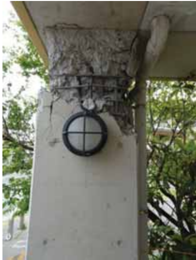
写真 3.5-1 主筋が座屈・破断した柱頭部
