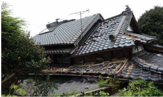
写真 3.3-8 倒壊した木造住宅
