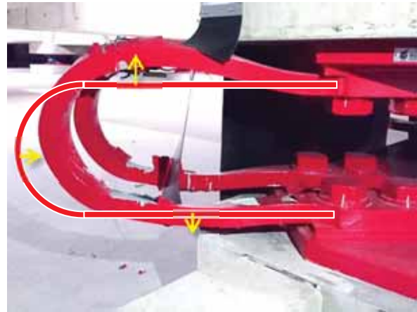
写真 3.7-7 鋼材部分の残留変形と塗装の はがれ (建築物B)
