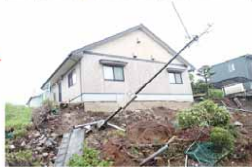
写真 3.6-1 県道 28 号線北側の ZoneB1 で見られた盛土擁壁の被害事例
