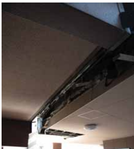
写真 3.7-8 エキスパンション部の変状 (建築物G：破損した天井被覆を撤去済み)
