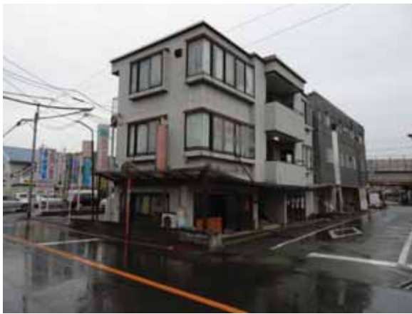
写真 3.6-9 地盤の液状化により沈下・傾斜したと思われる 3 階建て店舗併用住宅
