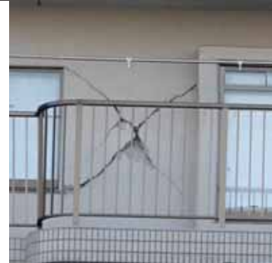
写真 3.5-3 付着割裂破壊した柱
