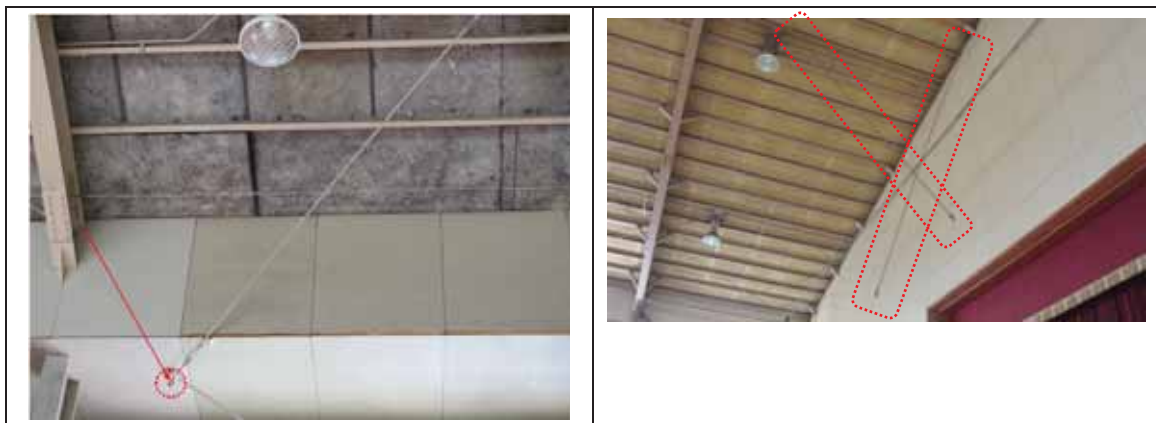
写真 3. 4-7 屋根面水平ブレースのボルト破断
