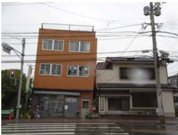
写真 3.6-7 地盤の液状化により沈下・傾斜したと思われる 3 階建て商用建築物
