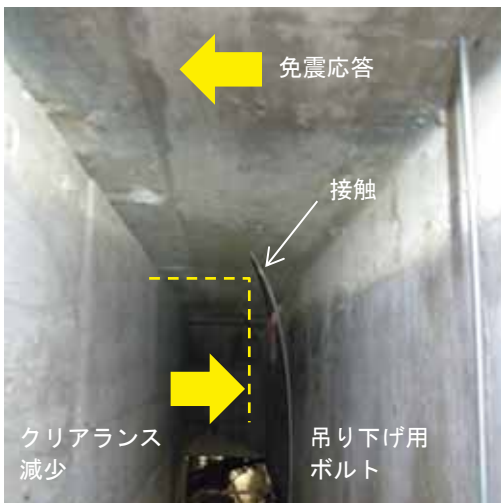
5 写真 3.7-10 クリアランス部の変状① (建築物F : 左は配管吊り下げ用ボルトの変形、右はオイルダンパー胴部の移動・接触に伴う周囲柵の変形)
