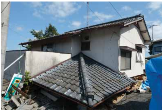
写真 3.3-2 倒壊した木造住宅
