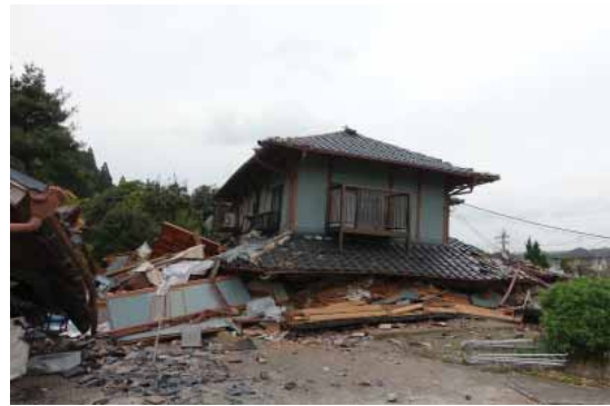
写真 3.3-9 倒壊した木造住宅
