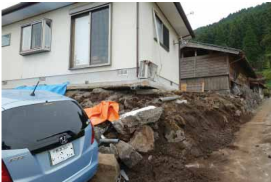
写真 3.3-10 崩壊した擁壁
