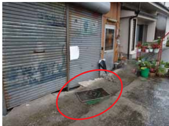
写真 3.6-7 地盤の液状化により沈下・傾斜したと思われる 3 階建て商用建築物
