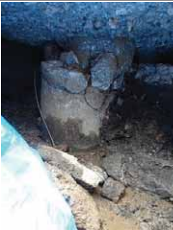
写真 3.5-7 コンクリート杭端部の損傷
