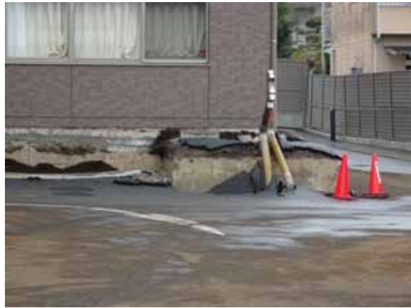
写真 3.6-8 地盤の液状化により周辺地盤が大きく沈下したと思われる病院とその沈下状況
