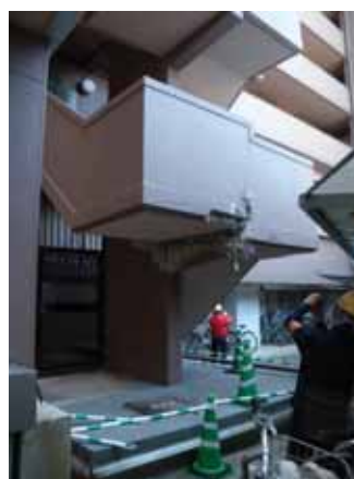
写真 3.7-4 外付け階段の被害 (建築物G)
