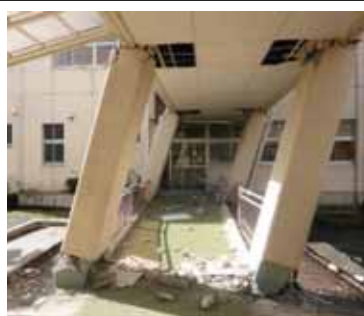
写真 3.5-5 3, 4層の損傷集中による大きな残留変形
