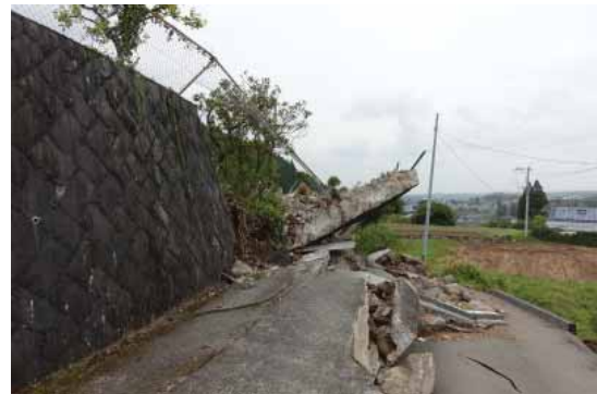
写真 3.3-11 崩壊した擁壁
