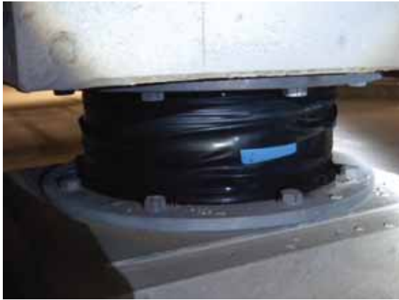
写真 3.7-6 化粧カバーのずれ及び胴部保護 ゴムのめくれ (建築物A)
