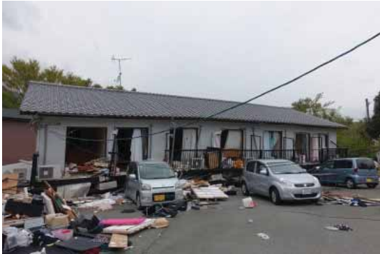
写真 3.3-12 倒壊した木造アパート
