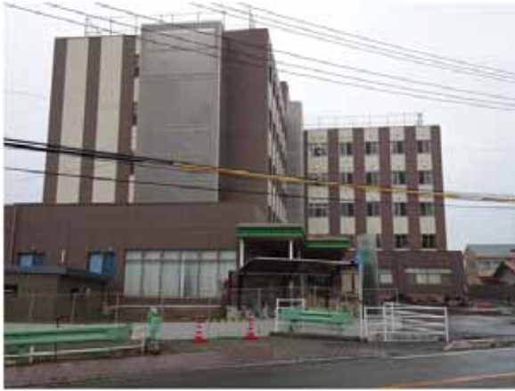
写真 3.6-8 地盤の液状化により周辺地盤が大きく沈下したと思われる病院とその沈下状況
