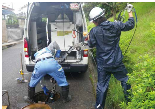
管口に衝撃弾性波検査装置を投入
