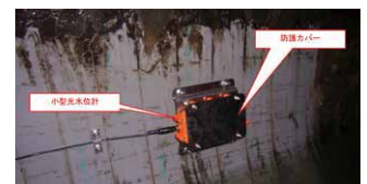
小型水位計設置の様子
