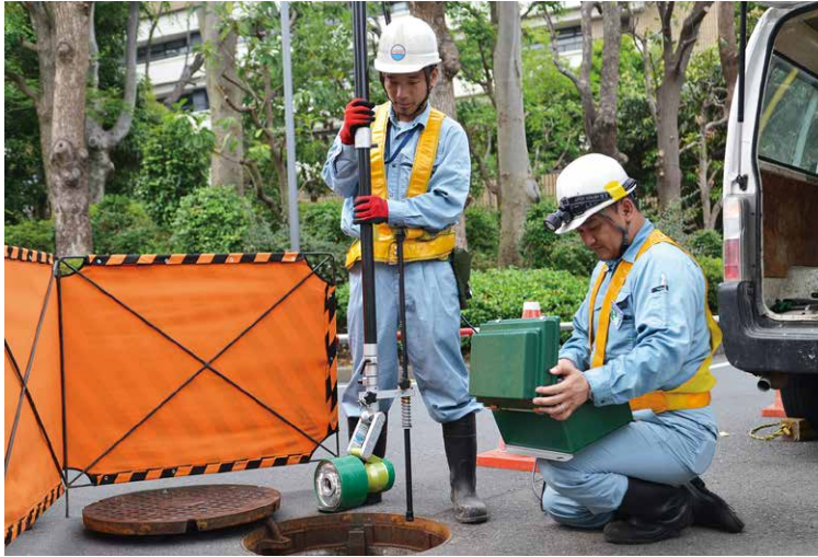
管口カメラ操作
