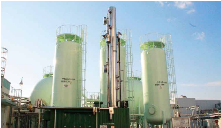
新型バイオマス精製設備
