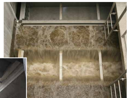
高速繊維ろ過槽
