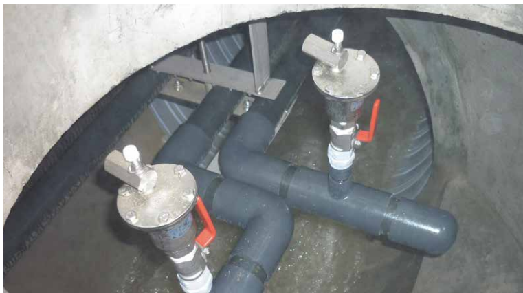
管路内下水流下状況
