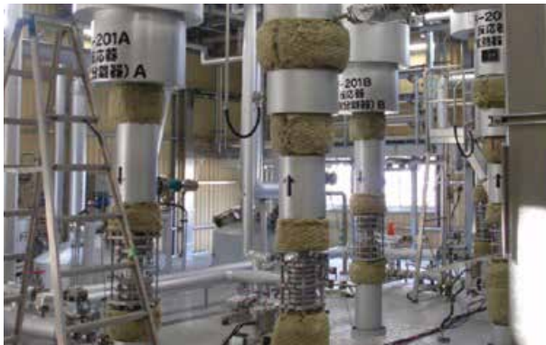
水熱反応機 (施工中)
