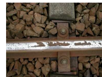
剥離損傷のイメージ※
