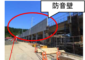
第2森越トンネルの緩衝工 トンネル緩衝工
