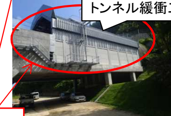
第2森越トンネルの緩衝工 トンネル緩衝工
