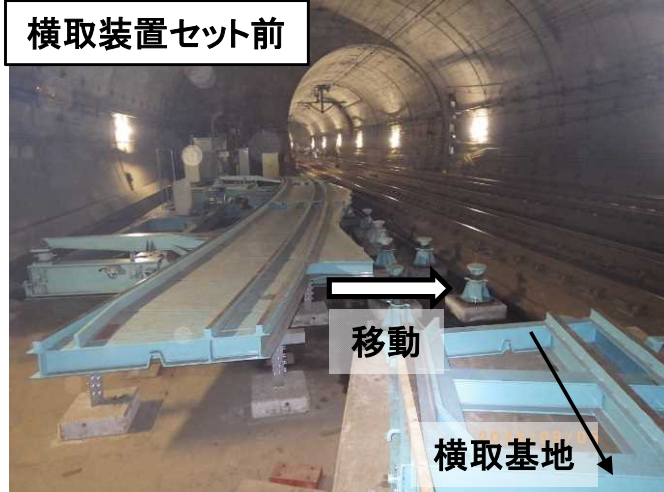
本線から横取基地への分岐(横取装置)
