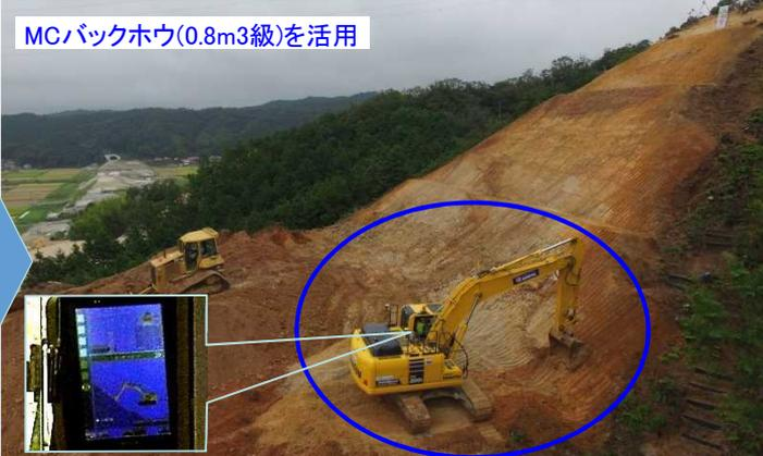
【今回】ICT建機を用いた掘削工事の施工状況
