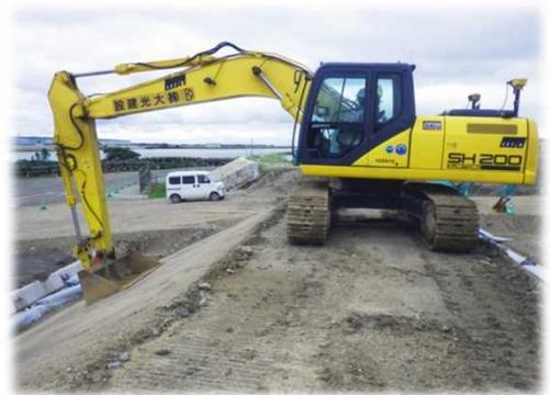
河川堤防の法面整形工におけるMGバックホウでの実効性を確認
