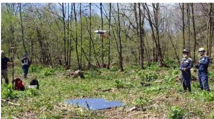
UAV(ドローン)による施工前の測量
