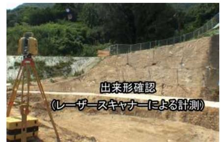
切土施工完了後、短時間での出来形計測可能。
