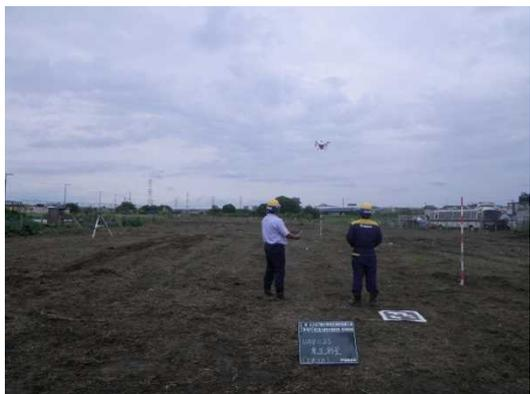
UAV(ドローン)による施工前の測量
