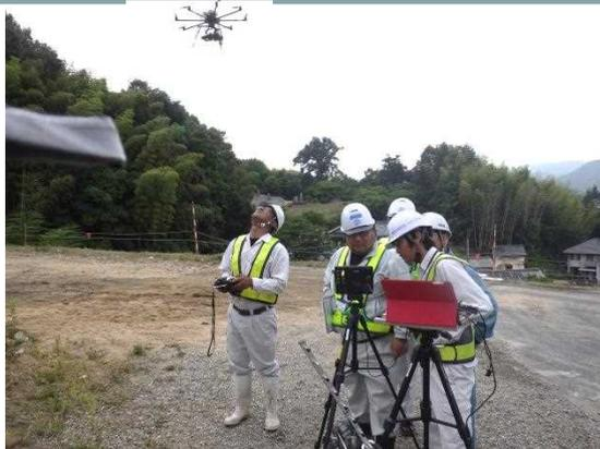
UAV(ドローン)による施工前の測量
