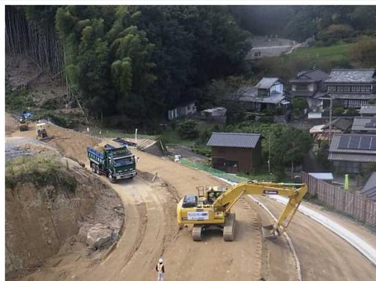
ICTバックホウによる削取整形
