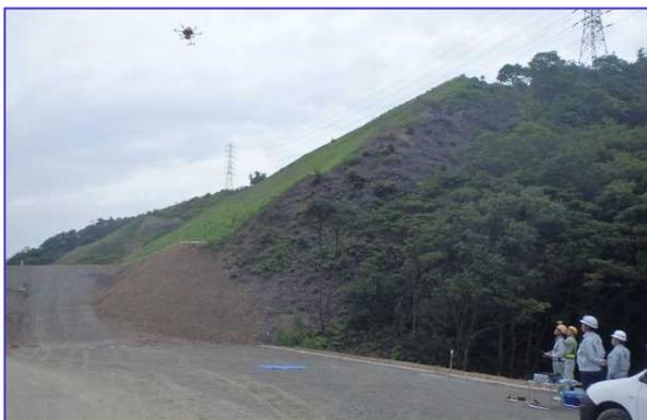
UAV(ドローン)による施工前の測量
