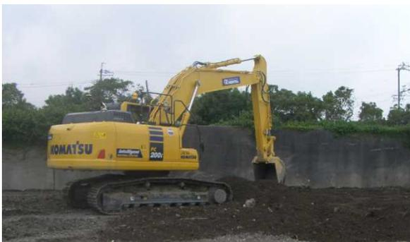
ICT建機(MCバックホウ)による施工
