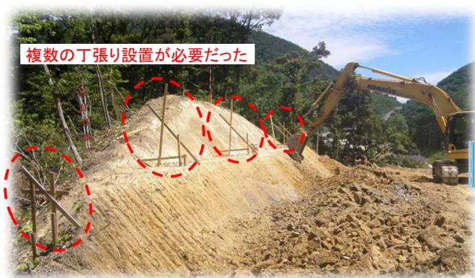
【従来】受注者が過去に施工した掘削工事の施工状況
