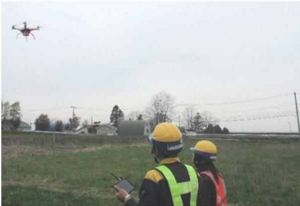
UAV(ドローン)による施工前の測量
