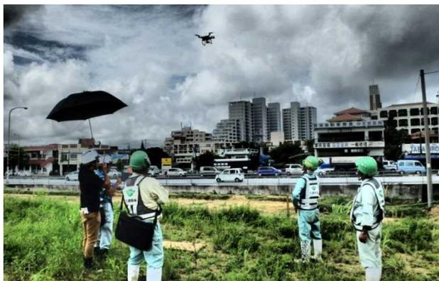
UAV(ドローン)による施工前の測量
