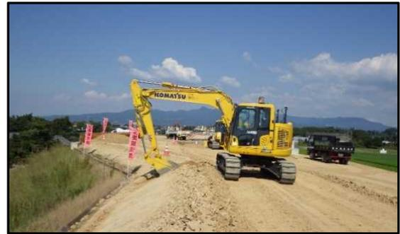
MCバックホーによる切土法面整形
