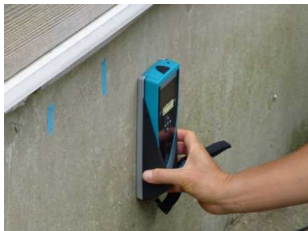
基礎(鉄筋関係)
