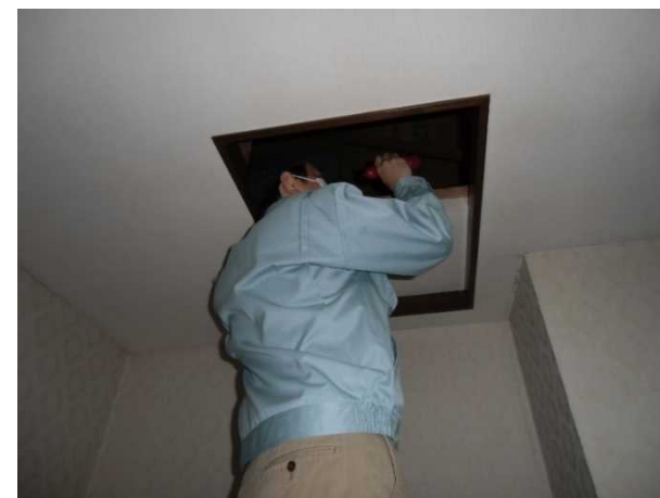
天井・小屋組
