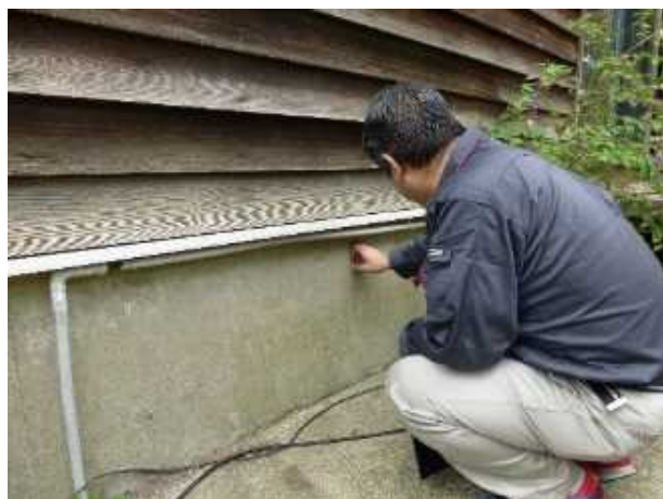
基礎(ひび割れ等)
