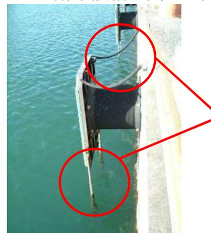
荷役作業の危険防止対策として、防舷材への係留ロープの引っ掛かりを防止する対策を考慮
