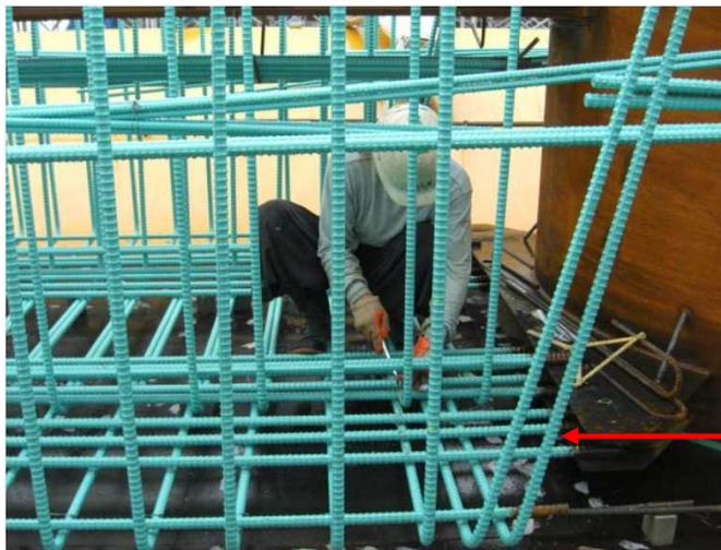
コンクリート構造部材の耐久性を向上させる方策としてエポキシ樹脂塗装鉄筋を適用
