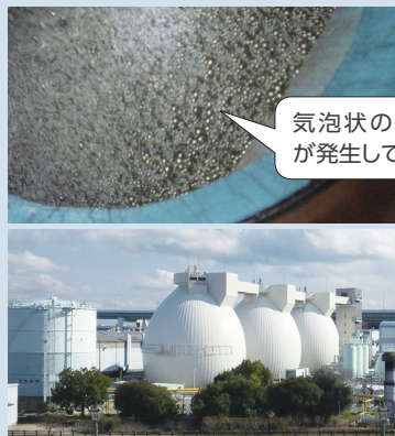
メタン発酵槽の中では気泡状のバイオガスが発生している。
