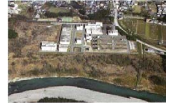
■吉野川浄化センター(H27年2月 撮影)
