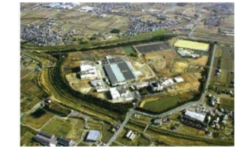
■第二浄化センター (H27年2月 撮影)
