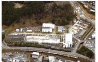
■宇陀川浄化センター(H27年2月 撮影)
