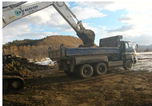
ダンプトラックへ積み込み、
