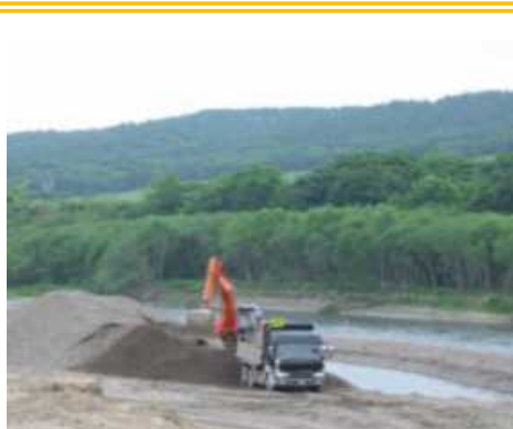
河道掘削した土砂を、
