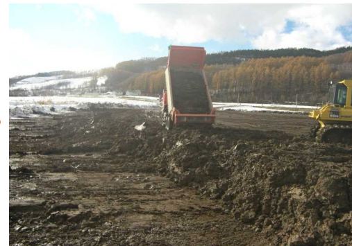
土砂が流出した農地へ運搬し、
