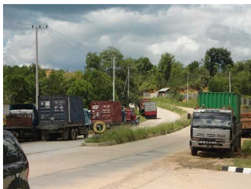
バリクパパン港から市内への道路 舗装の質が悪く穴が多い
