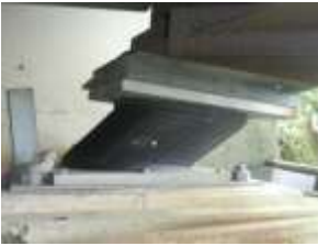
写真-3 パラペット・ゴム支承の破壊 (俵山大橋A2橋台)
