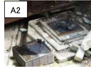
写真-5 各下部構造で異なるゴム支承の破壊形態 (大切畑大橋)
