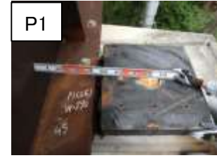
写真-5 各下部構造で異なるゴム支承の破壊形態 (大切畑大橋)
