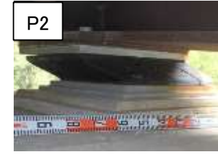
写真-5 各下部構造で異なるゴム支承の破壊形態 (大切畑大橋)
