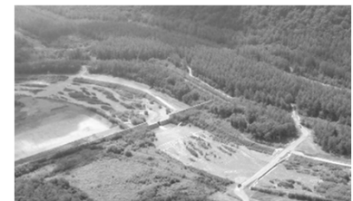
美瑛川第8号砂防堰堤（美瑛町）
