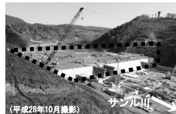
工事中のサンルダム
