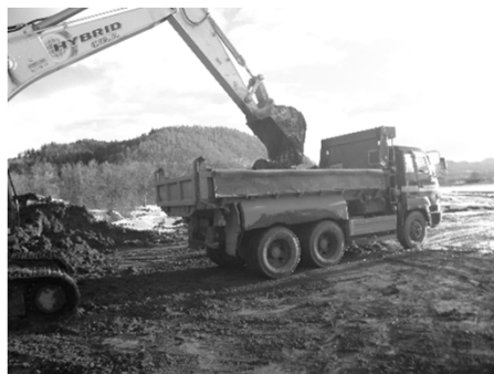
常呂川の河道掘削土の積込状況
