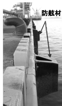
大型クルーズ船に対応した係船柱・防舷材の設置
