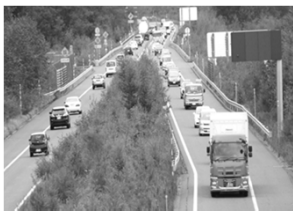
道東自動車道 十勝清水IC付近
