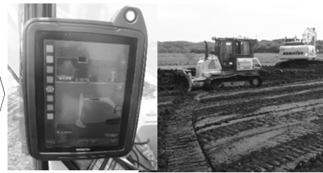
ICT建機による施工
