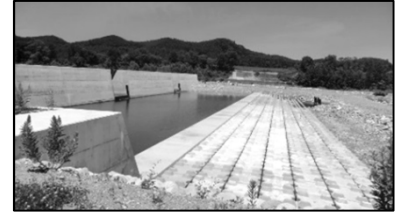
再度災害防止のため砂防堰堤等を整備
