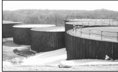
樽前山における砂防堰堤の整備
