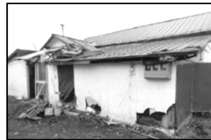
越波による家屋等の被害 (苫小牧市)
