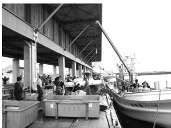
【高度衛生管理対策：屋根付き岸壁、清浄海水施設】
