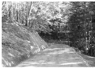
路網（森林作業道）の整備
