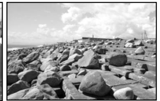
護岸へ基礎石が飛散 (苫小牧市)
