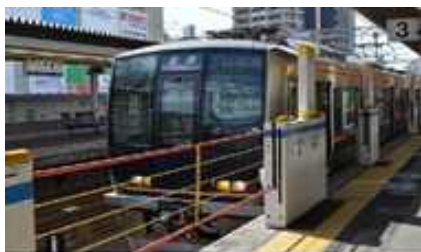
○昇降ロープ式ホーム柵(支柱伸縮型)
