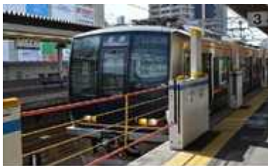
○昇降ロープ式ホーム柵 (支柱伸縮型)
