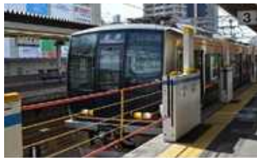
○昇降ロープ式ホーム柵(支柱伸縮型)
