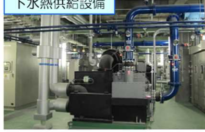
下水熱供給設備
