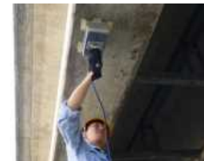
↑コンクリート構造物かぶり部の塩化物含有量を面的に迅速に測定する技術
