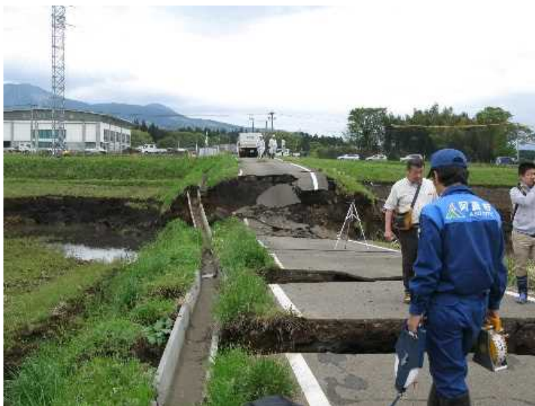
亀裂によって大きく損壊した農道と用水路
