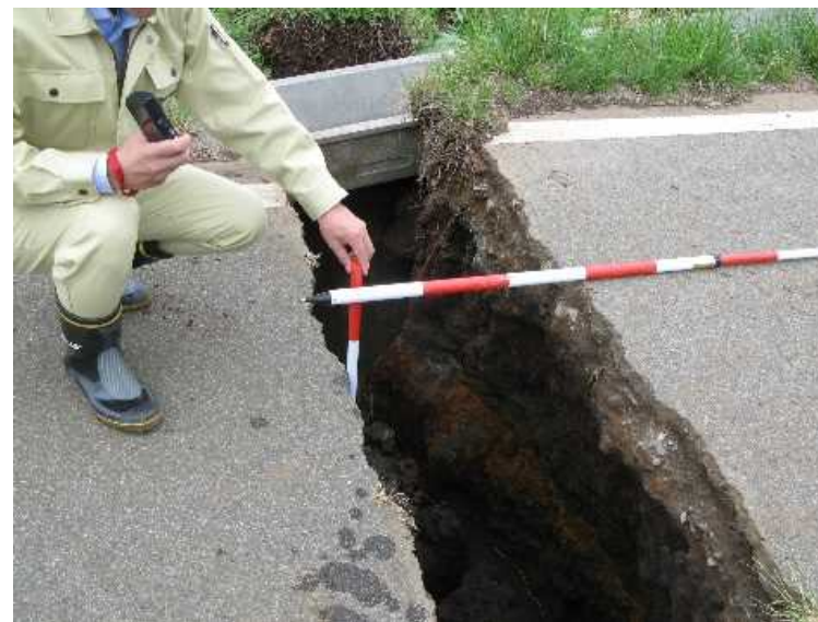
亀裂によって農道に生じた開口
