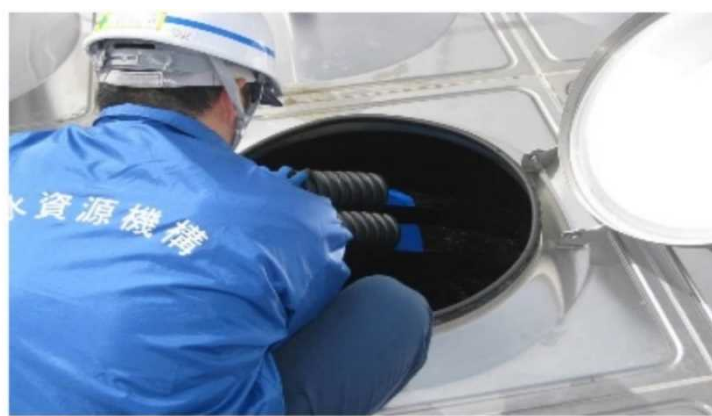
＜給水槽への浄化水注入状況＞
