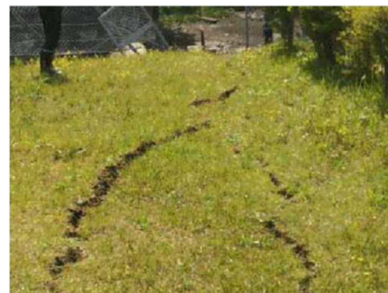
堤体のひび割れ
