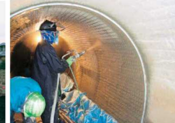
(水路トンネル内面の補強)
