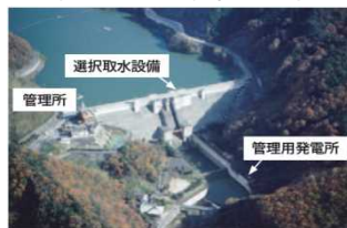
管理用発電設備(S58.5運転開始)
