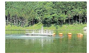
曝気循環設備(大山ダム)
