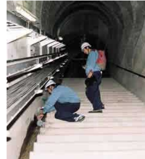
ダム堤体の観測及び施設点検
