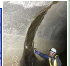
水路トンネル内の調査
