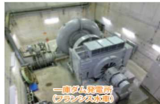
一庫ダム発電所(フランス製100kW)
