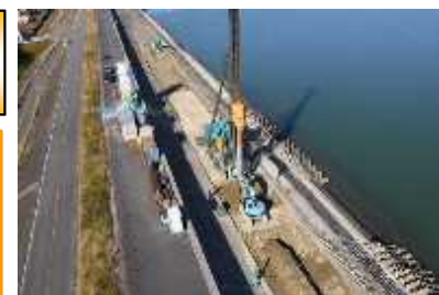
▲施設の耐震化等 (木曾三川下流堤防等)
