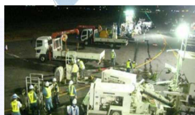
限られた時間での夜間作業
