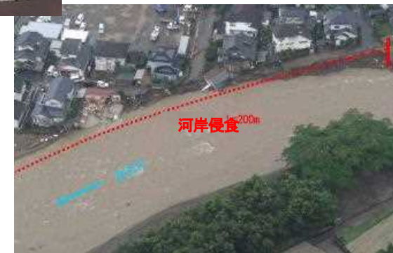
河岸侵食に伴う 家屋倒壊等
