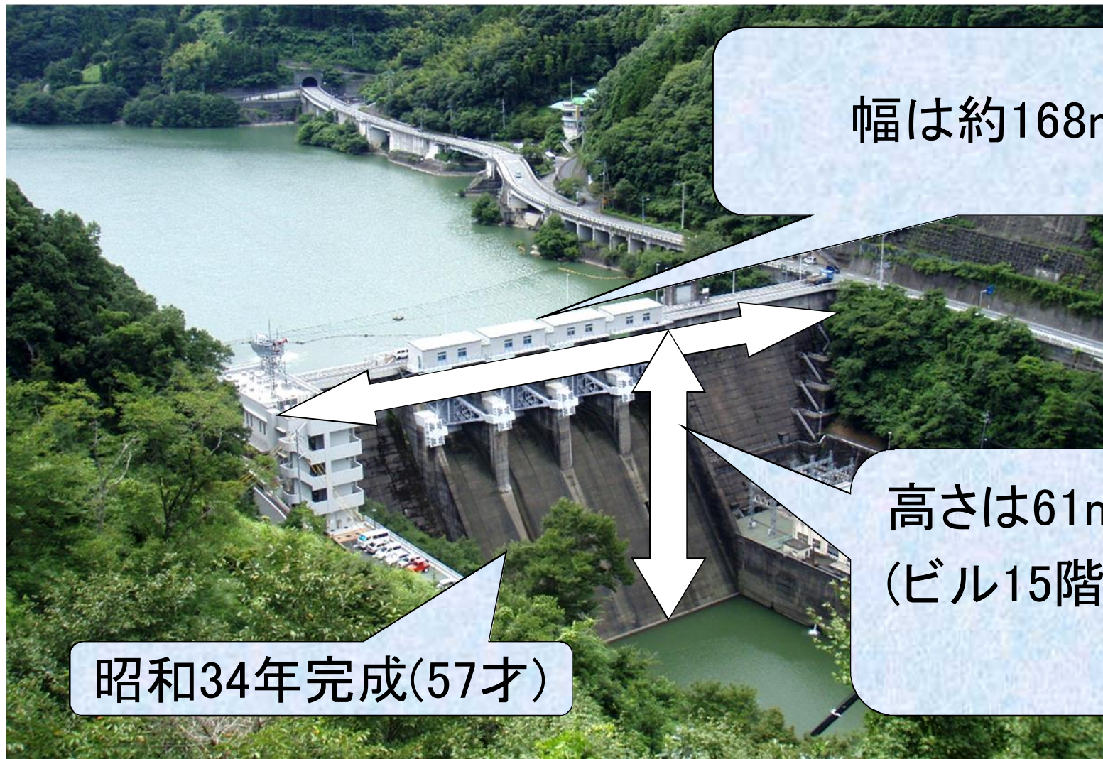
鹿野川ダム(重力式コンクリートダム)
