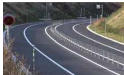
＜ワイヤロープの設置事例＞
