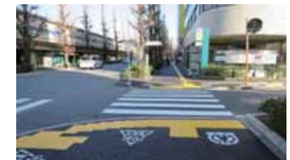
<歩道の整備(千駄ヶ谷駅周辺)>
