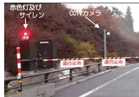
&lt;遠隔操作遮断機の導入&gt;
