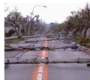
<電柱の倒壊による道路閉塞>
