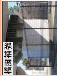
落橋防止構造
