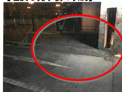
【埋戻し完了後の状況】
