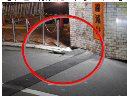
【市道の陥没発生直後の状況】
