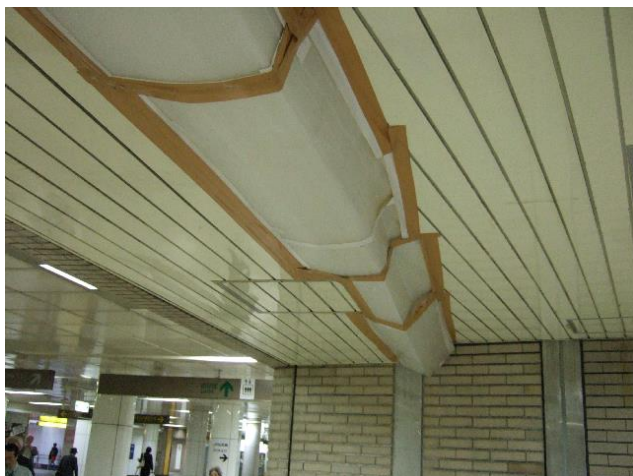
地下通路の漏水の様子
