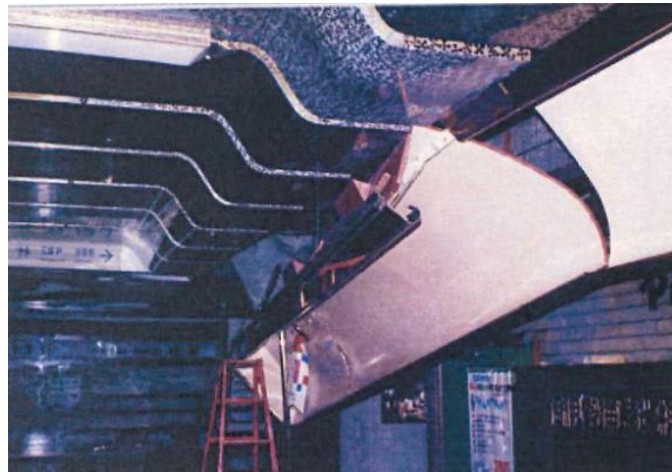
吊り天井の脱落被害の様子
