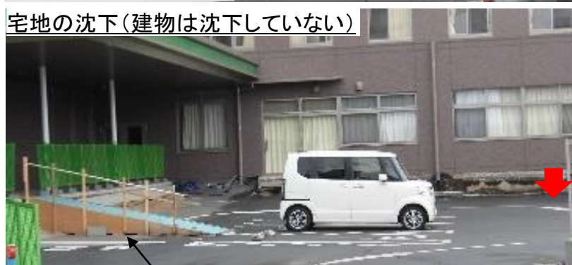
地震後に斜路を応急復旧
