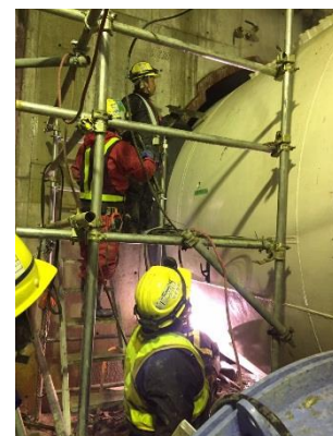
【シールド機で立坑内横穴を塞いでいる状況】
