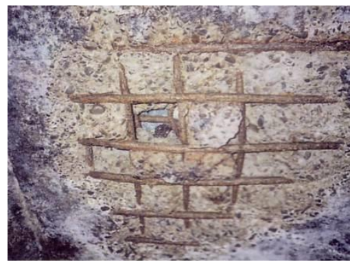
●管路の腐食の例
