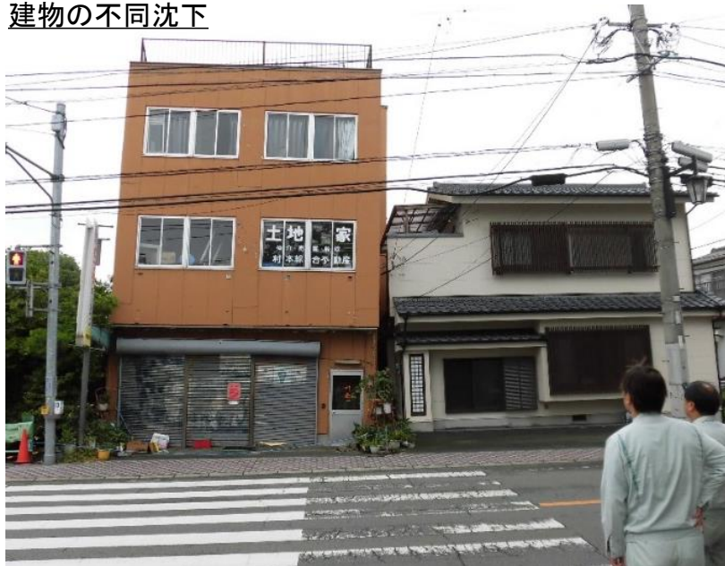
宅地の沈下(建物は沈下していない)
