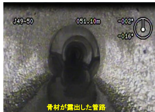
●管路の老朽化の例
